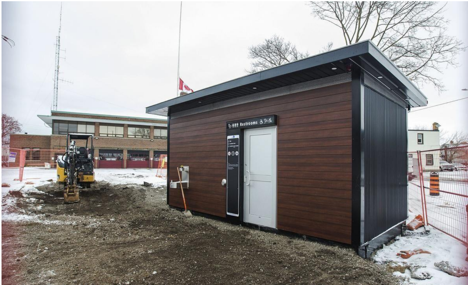
Des toilettes publiques autonomes sont en cours d'installation à l'intersection des rues St. Paul, Geneva et Niagara. Bob Tymczyszyn / Torstar
