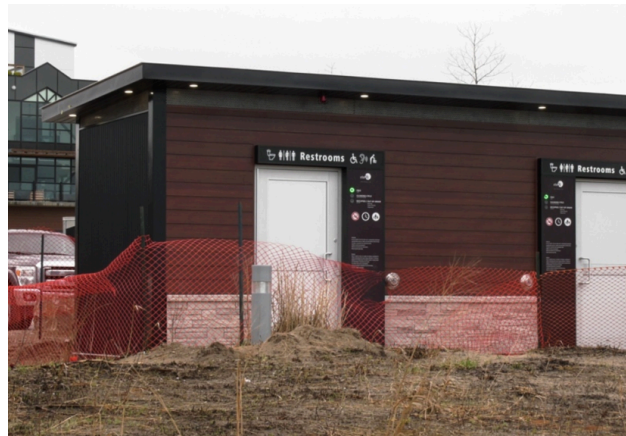
De nouvelles toilettes intelligentes sont en cours d'installation à Grand Bend. 17 av Bicknell/CTV News Londres)
